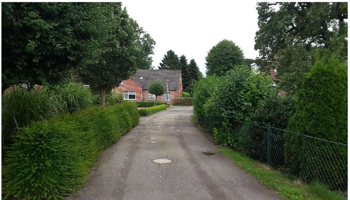
Abb. 16 Aktueller Ausbaustandard des Achterwegs mit Engstelle
