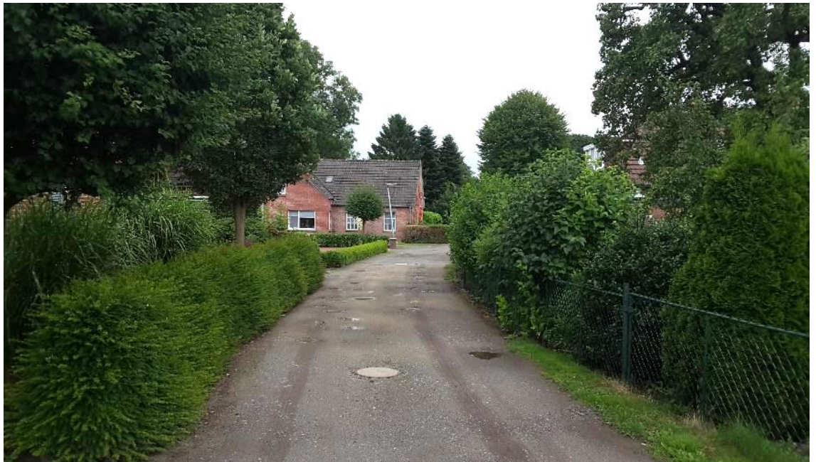
Abb. 15 Aktueller Ausbaustandard des Achterwegs mit Engstelle
