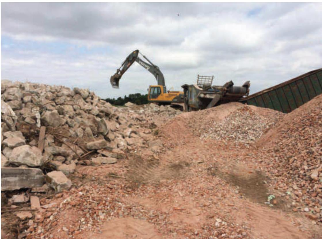
Foto 16: Aufbereitung der mineralischen Bausubstanz zu Recyclingschotter
