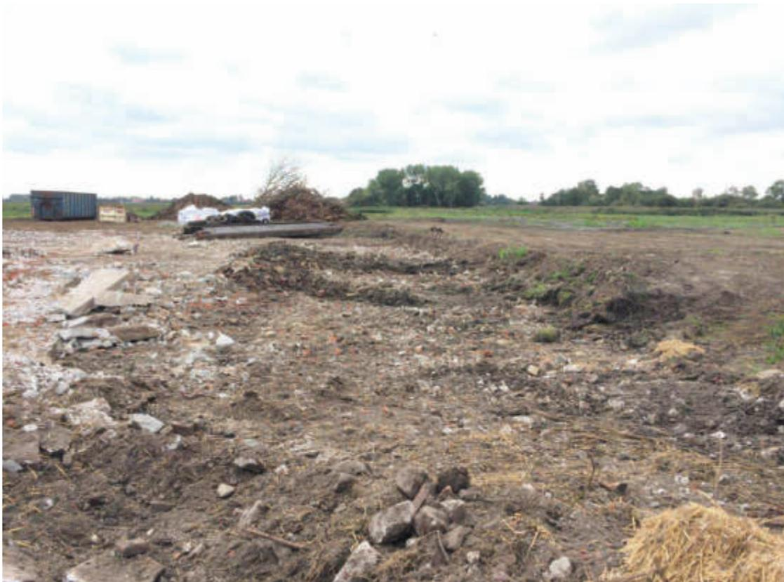
Foto 14: Ausbau Packlage / Tragschicht unterhalb der befestigten Außenflächen
