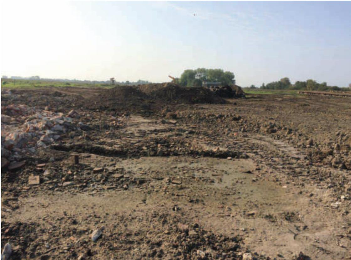
Foto 15: Ausbau Packlage / Tragschicht unterhalb des Stalls
